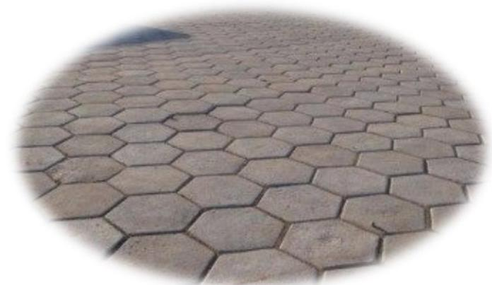
Figura 8: Imagem do assentamento do bloco pré-moldado intertravado sextavado.
