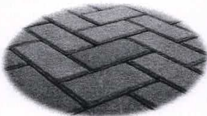
Figura 7: Imagem do assentamento do bloco pré-moldado intertravado retangular (escama de peixe).
