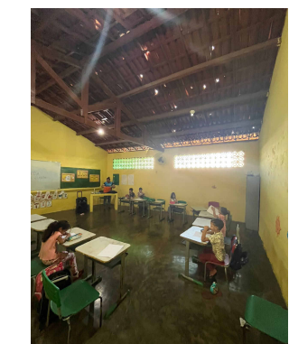
-CONSTRUÇÃO DE PISO CERÂMICO EM TODAS AS SALAS -REVESTIMENTO CERÂMICO 30x30 NAS PAREDES H=1,10m -FORRO DE GESSO EM TODAS AS SALAS -8 LUMINÁRIAS EM CADA SALA
