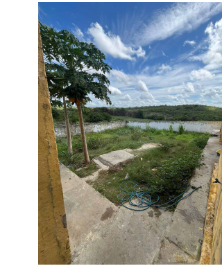
-CONSTRUÇÃO DE DUAS NOVAS SALAS DE AULA COM PISO CERÂMICO, FORRO DE GESSO E LUMINÁRIAS DE LED
