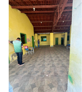
-RESTAURAÇÃO 70% DO PISO CERÂMICO DO REFETÓRIO E PÁTIO -20 LUMINÁRIAS DE LED NO PÁTIO E REFETÓRIO
