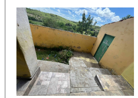
-REPARO NA RAMPA DE ACESSO E DEGRAUS
