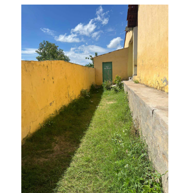
-CONSTRUÇÃO DE PISO INDUSTRIAL A= 27.52m 2
