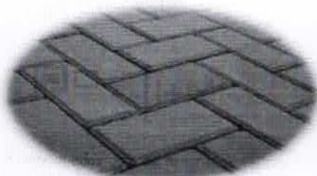
Figura 04: Imagem do assentamento do bloco pré-moldado intertravado retangular (escama de peixe).
