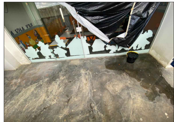
RECUPERAÇÃO COMPLETA DE PISO COMPROMETIDO POR INFILTRAÇÕES
