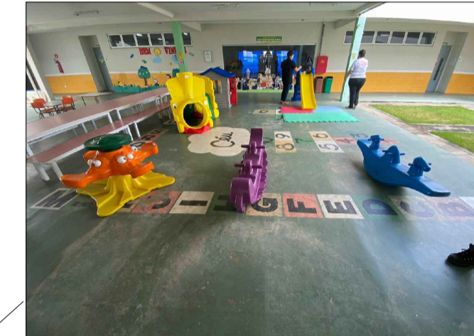
RECUPERAÇÃO DE PINTURA COMPLETA DO PISO DO PÁTIO
