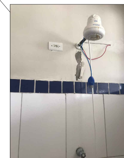
TROCA DE CHUVEIRO DANIFICADO E REPARO DE INFILTRAÇÃO, REBOCO E PINTURA
