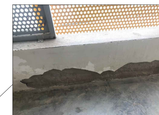
REPARO DE DESPLACAMENTO DE REBOCO E PINTURA
