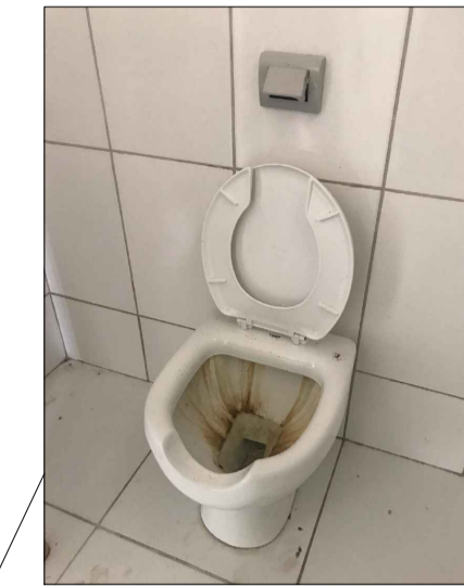
TROCA DE BACIA SANITÁRIA DANIFICADA
