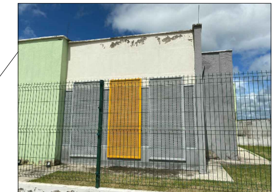
SUBSTITUIÇÃO DE COMPLETA DE CHAPIM E RECUPERAÇÃO DA PINTURA DA FACHADA
