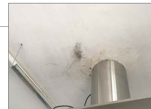
REPARO DE INFILTRAÇÃO NO FORRO DE GESSO
