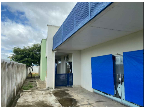
RECUPERAÇÃO COMPLETA DE CALÇADA
