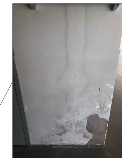
REPARO DE INFILTRAÇÃO, DESPLACAMENTO DE REBOCO E PINTURA
