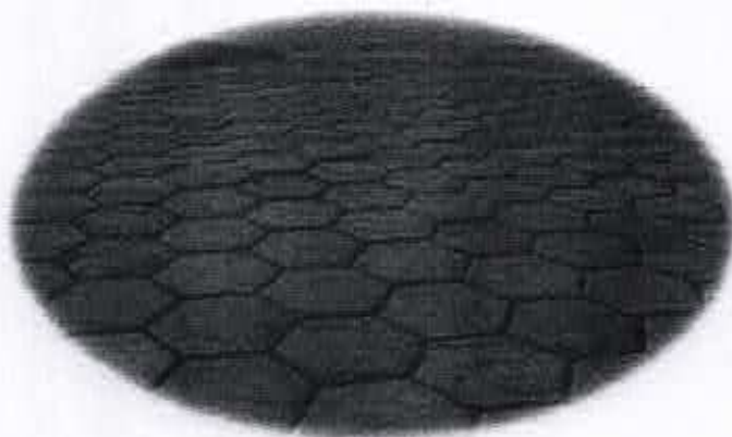
Figura 8: Imagem do assentamento do bloco pré-moldado intertravado sextavado.
