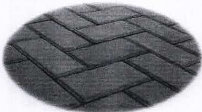
Figura 7: Imagem do assentamento do bloco pré-moldado intertravado retangular (escama de peixe).
