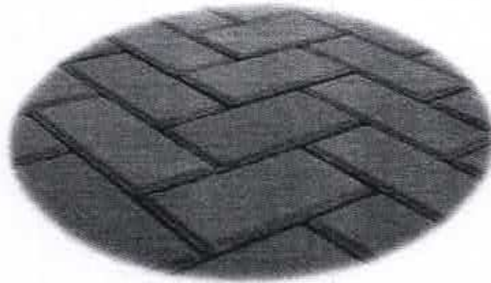
Figura 5: Imagem do assentamento do bloco pré-moldado intertravado retangular (escama de peixe).
